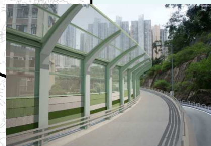
連德道與秀茂坪道路口 道路改善工程
